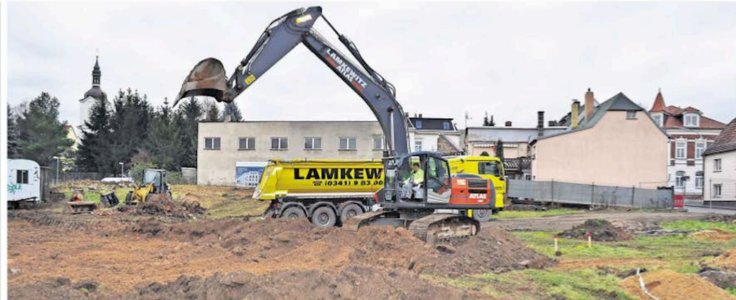
Auf der Brachfläche in der Leipziger Straße/Ecke Bahnhofstraße tut sich was: Bis Anfang 2018 wird hier das Gesundheitszentrum Zwenkau gebaut.
