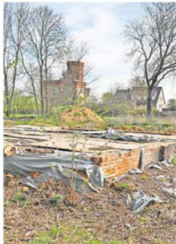
Auf dem Gelände des alten Gaswerks wird demnächst eine Teergrube entsorgt.
