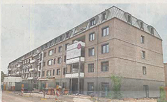
Das bislang größte Leipziger Vorhaben in Holzhybrid-Bauweise ist fast fertig. Seit Oktober 2022 entstanden dabei 111 neue Seniorenapartments und ein Pflegedienstpunkt an der Beckerstraße nahe dem Lindener Hafen. Der Bauherr Wincon hat 30 Millionen Euro investiert.
