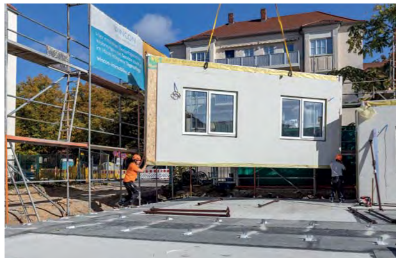
▲ Einheben eines Außenwandelements mit dem Kran
