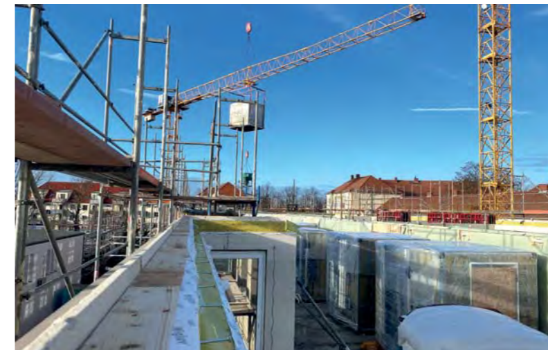
◀ Die fertig angelegten Bäder stehen zum Einbau bereit
