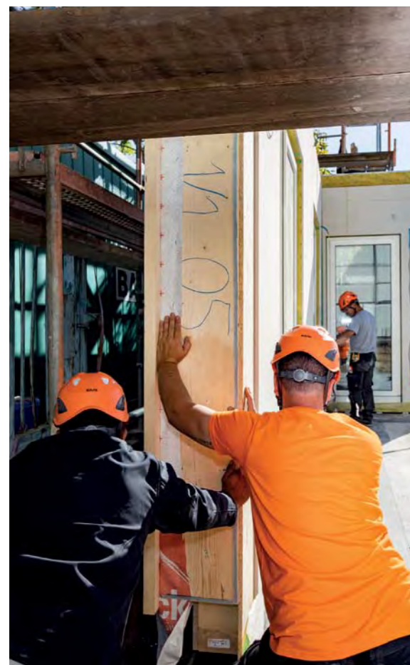
▲ Alle Wände wurden im Werk seriell vorproduziert und vor Ort nur noch montiert
