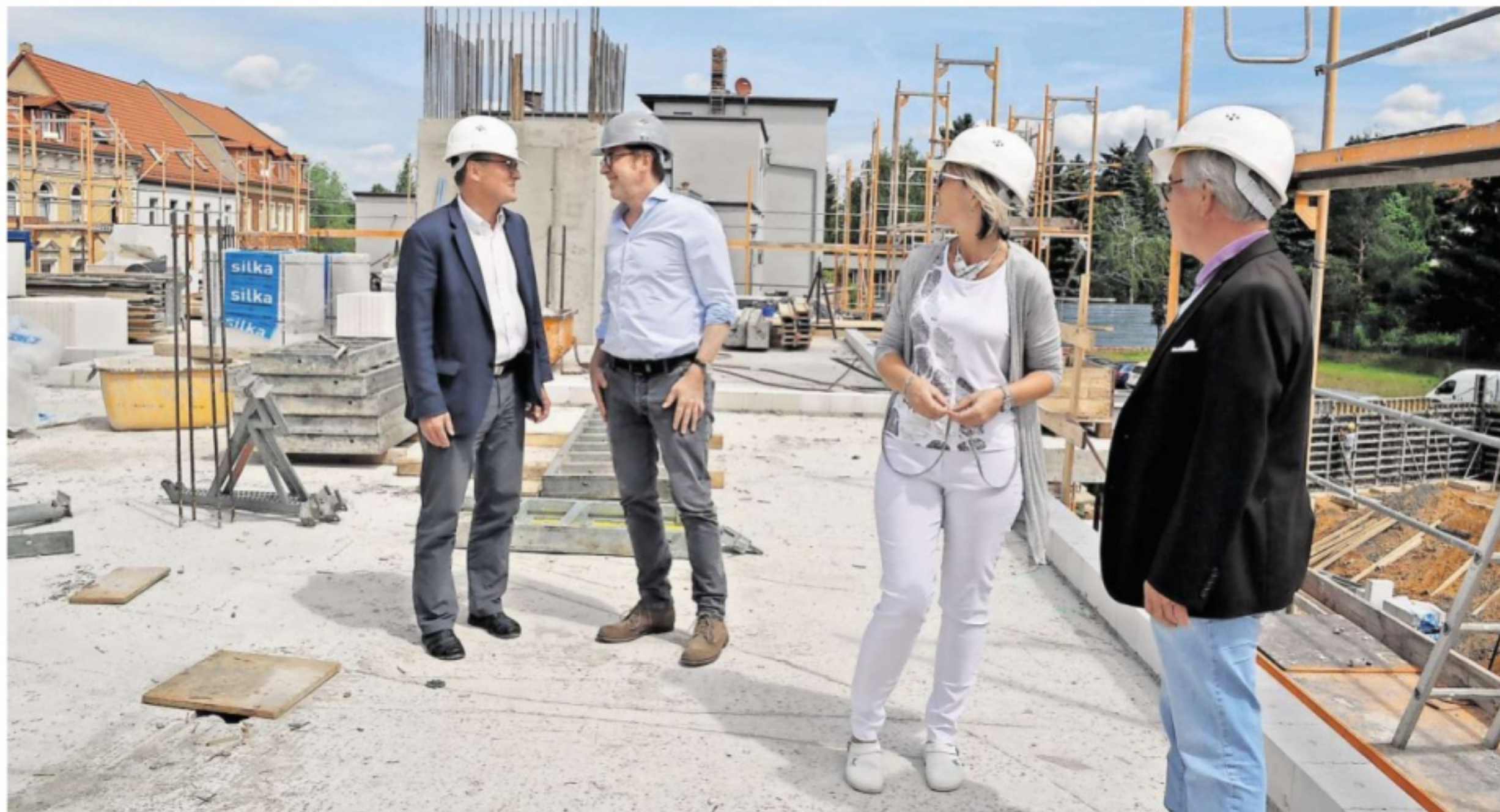
Besuch im künftigen Gesundheitszentrum: Bürgermeister Holger Schulz (links) schaut sich auf der Baustelle um. Mit dabei ist auch Heike Oehlert.
